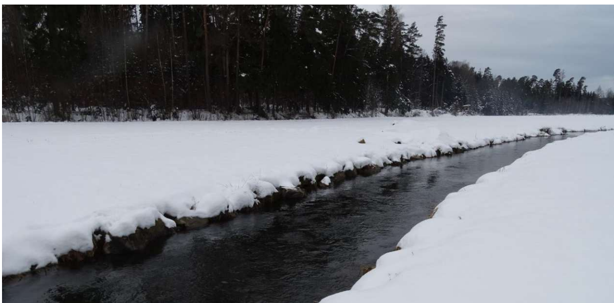
Abb. 3: Die Bayerische Schwarzach Richtung Witzelsmühle: Ufergehölze fehlen vollständig. Im Ausbaubereich ab Fl. km. 0,9 verhindert die Ufersicherung durch Blocksteine jede eigendynamische Entwicklung des Gewässers
